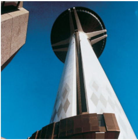
Verlegung von Spaltplatten auf Beton mit Kerabond T + Isolastic - Neuer Telekommunikations-Tower - Kuwait City (Kuwait)
