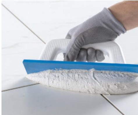
Kerapoxy Easy Design mit Mapei-Gummifugscheibe auftragen
