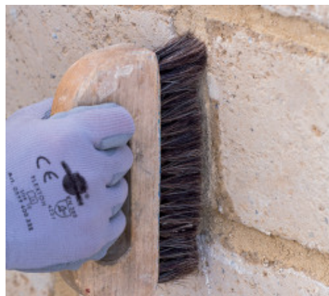
Finish der Mörtelfuge
