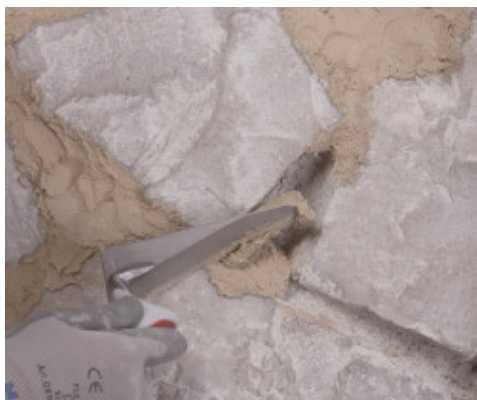
Schließen der Fugen einer Bruchsteinmauer
