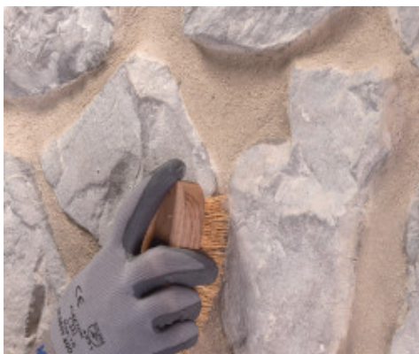
Freilegen der Fugen mit einer Handbürste
