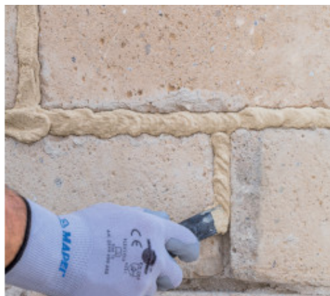
Entfernen von überschüssigem Mörtel
