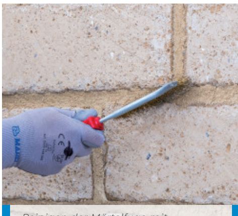
Reinigen der Mörtelfuge mit geeigneter Bürste
