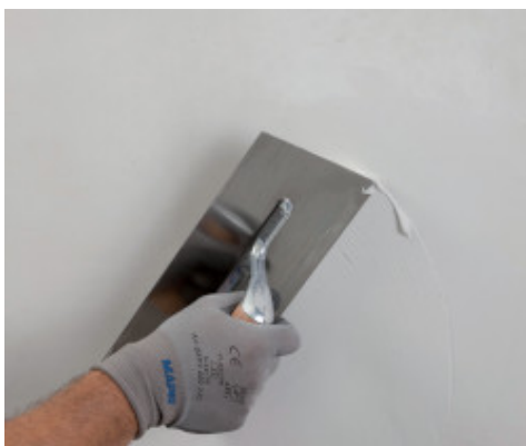
Applikation von Mape-Antique FC Ultrafine mit einer Stahltraufel
