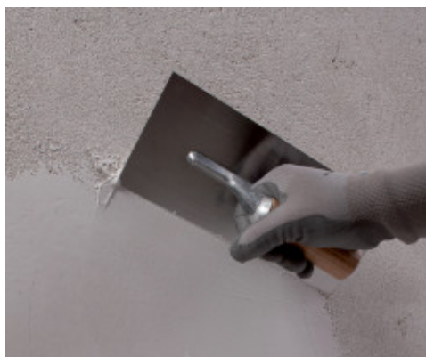
Auftrag der ersten Lage von Mape-Antique FC Ultrafine
