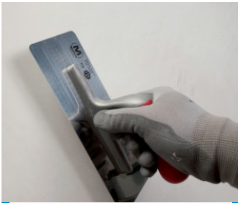
Auftrag einer zweiten Lage von Mape-Antique FC Ultrafine
