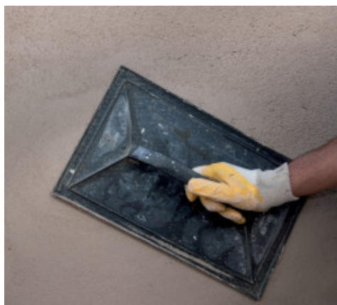
Glätten des Putzes
