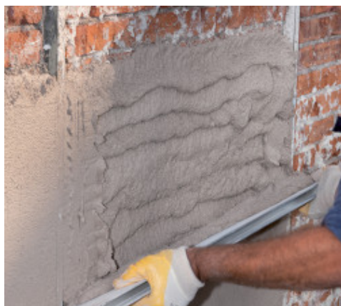
Ebnen des Putzes
