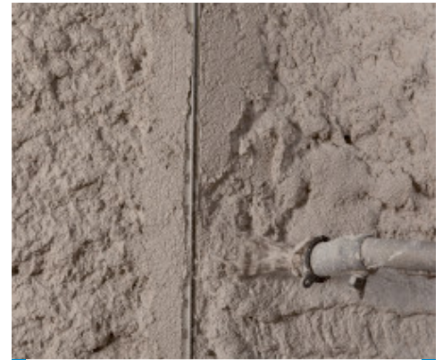
Applikation von Mape-Antique MC Macchina
