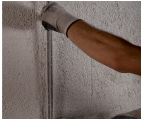
Entfernen der vertikalen Führung
