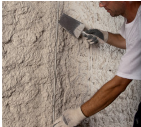
Einbau einer vertikalen Führung
