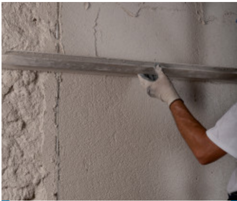
Abziehen von Mape-Antique MC Macchina mit Latte
