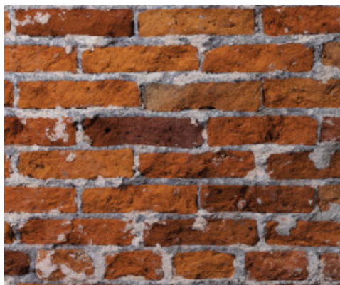
Ziegelmauer nach dem Abschlagen von geschädigtem Putz
