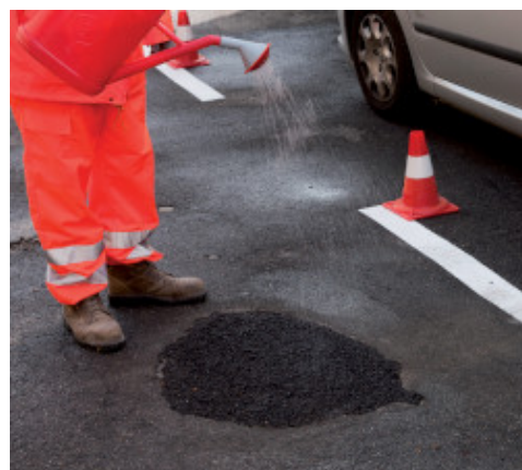
Wässerung der Oberfläche
