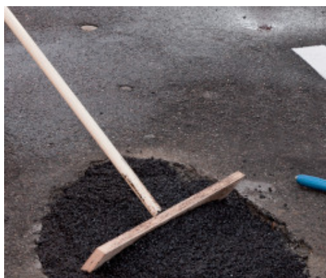
Einbringen und Verarbeiten von Mape-Asphalt Repair 0/8
