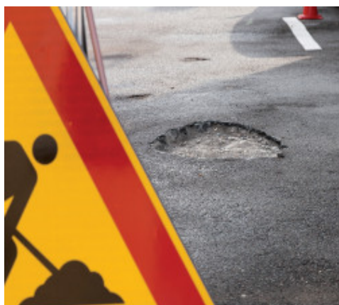
Reparaturstelle im Straßenbelag
