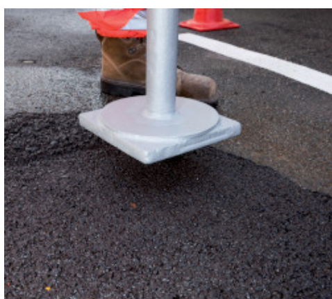
Manuelle Verdichtung
