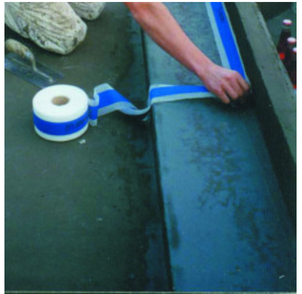
Einarbeiten von Mapeband im Boden-Wandanschluss eines Beckens
