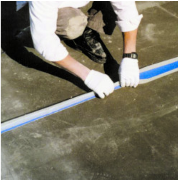
Abdichtung einer Dehnungsfuge auf einer Terrasse
