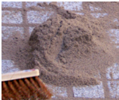
Reinigen der gefugten Fläche mit einem Besen
