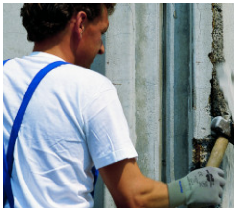
Abbruch von geschädigtem Beton
