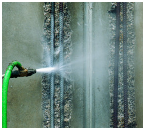
Reinigung der Bewehrung
