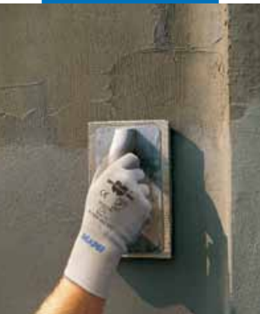
Glätten mittels Glättkelle
