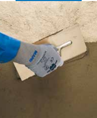
Verarbeitung im Spachtelverfahren
