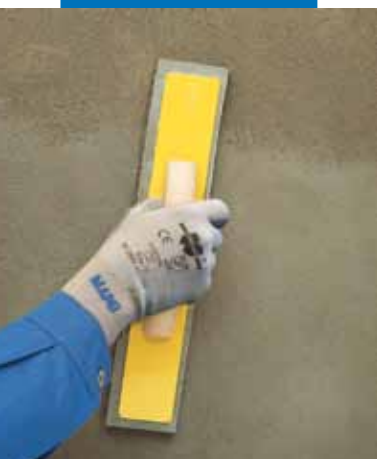
Glätten mittels Schwamm Brett
