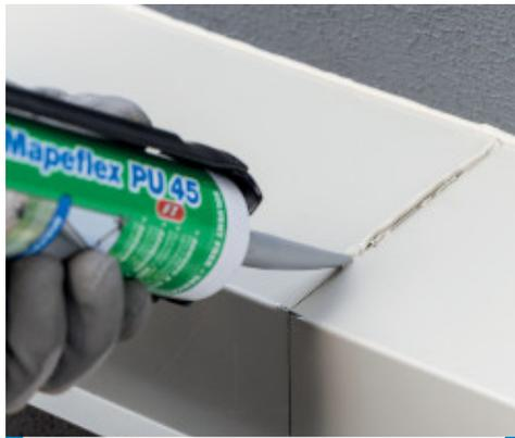
Flexibles Verschließen von Bauteilfugen
