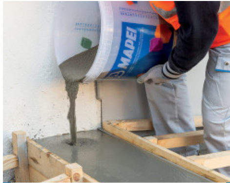
Instandsetzen und Verbreitern einer Betonwand mit Mapegrout Ancora & Ripara
