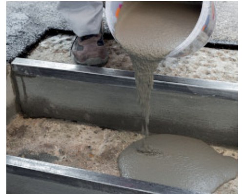
Instandsetzen einer Betonstufe mit Mapegrout Ancora & Ripara
