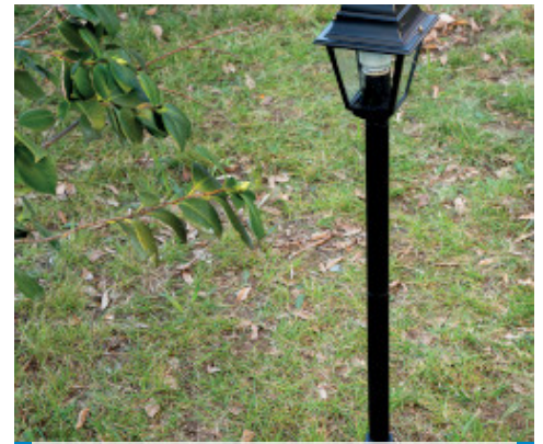
Verankerung eines Laternenpfahls mit Mapegrout Ancora & Ripara
