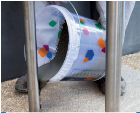
Verankerung einer Straßenmöblierung mit Mapegrout Ancora & Ripara
