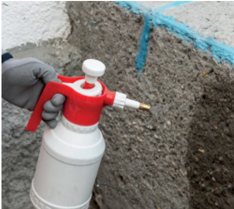
Benetzen des Untergrunds
