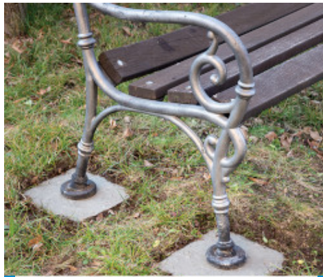
Verankerung einer Sitzbank mit Mapegrout Ancora & Ripara
