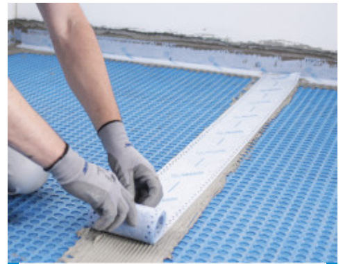
Abdichten der Fugen zwischen Bahnen mit Mapeband Easy, verklebt mit Mapeguard WP Adhesive
