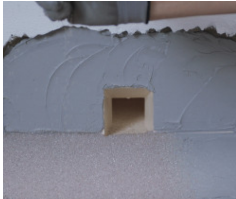
Abdichten von Abläufen mit Drain Front
