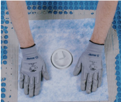
Abdichten von Abläufen mit Drain Vertical/Drain Lateral
