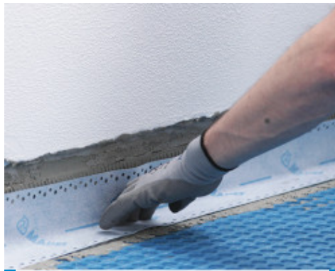
Abdichtung der Ränder mit Mapeband Easy, verklebt mit Mapeguard WP Adhesive
