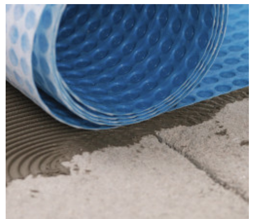
Ausrollen von Mapeguard UM 35
