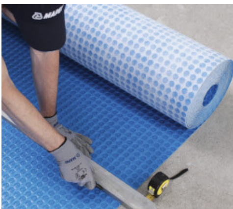
Zuschneiden von Mapeguard UM 35
