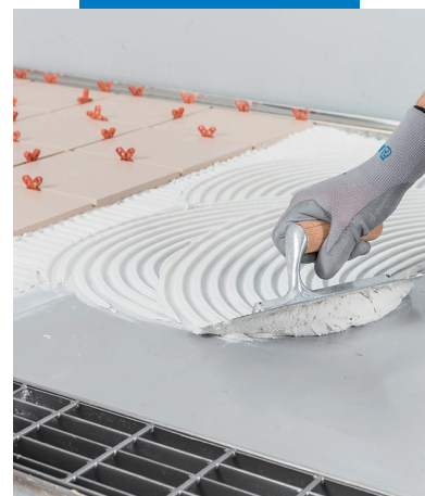
Belagsverlegung mit Kerapoxy
