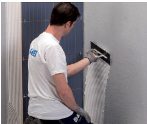
Ansetzen des Belags mit Ultramastic III
