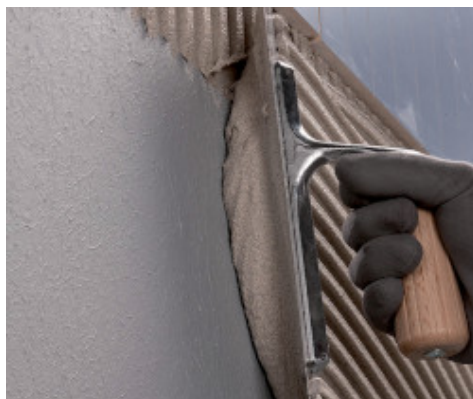
Ansetzen des Belags mit Keraflex S1
