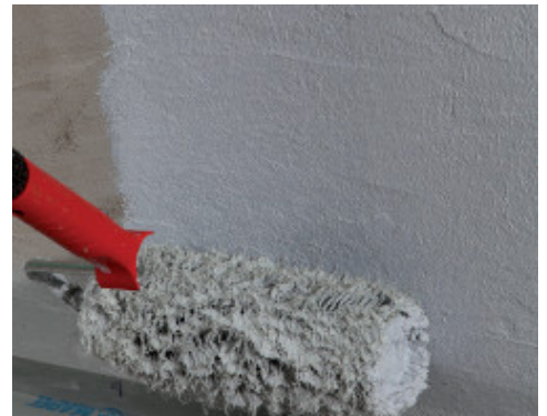
Auftragen von Mapegum WPS mit einer Rolle
