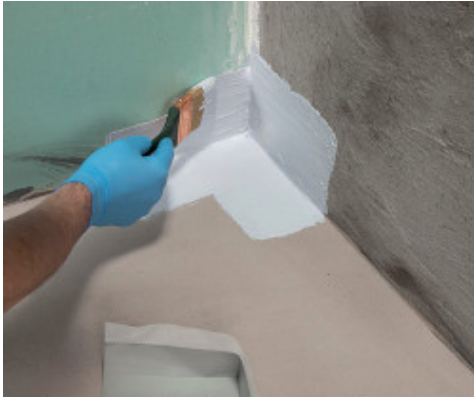
Einbau einer Mapeband PE 120 Innenecke mit Mapegum WPS
