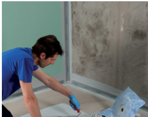
Einbau eines Bodenablaufs mit Mapegum WPS
