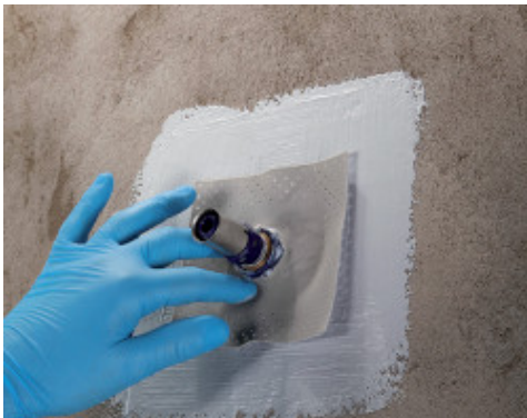
Einbau einer Mapeband PE 120 Wanddichtmanschette mit Mapegum WPS
