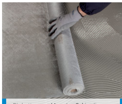
Einbetten von Mapetex Sel in die frische erste Schicht von Mapelastich Turbo
