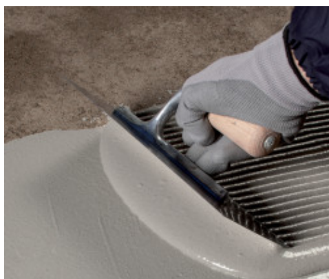
Auftragen der ersten Schicht von Mapelastich Turbo
