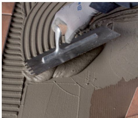
Verlegung der Fliesen mit Elastorapid
