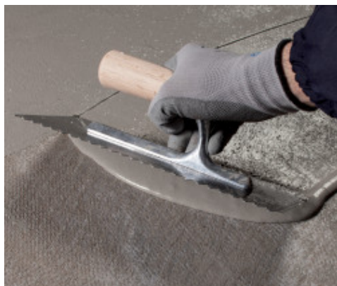
Auftrag der zweiten Schicht Mapelastich Turbo auf Mapetex Sel
