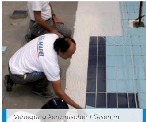
Verlegung keramischer Fliesen in einem Schwimmbecken auf eine Abdichtungsschicht aus Mapelastic
