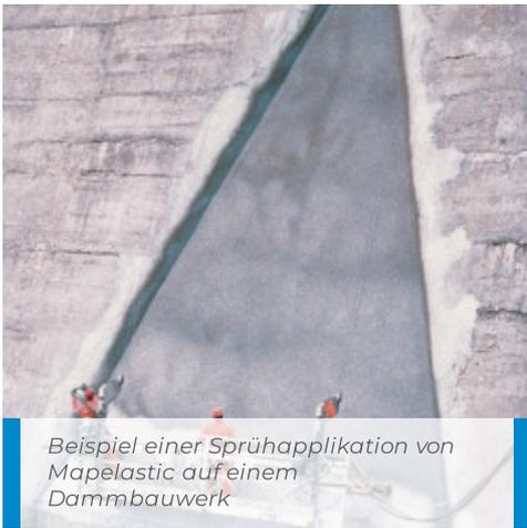
Beispiel einer Sprühapplikation von Mapelastic auf einem Dammbauwerk
