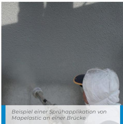
Beispiel einer Sprühapplikation von Mapelastic an einer Brücke
