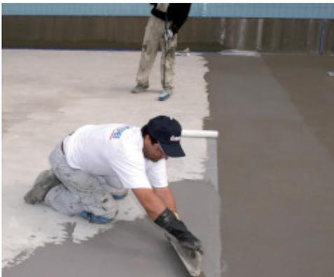
Abdichtungsarbeiten an einem Schwimmbecken mit Mapelastic
