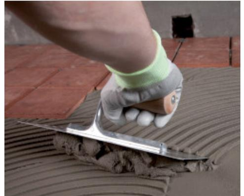
Auftrag von Granirapid auf einer mit Mapelastic abgedichteten Terrasse
