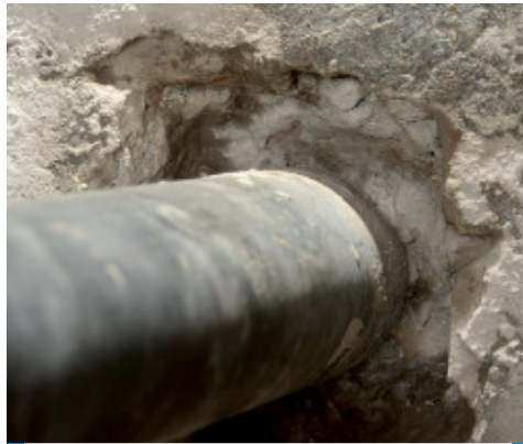
Abtragen des Betons rund um die Leitung
