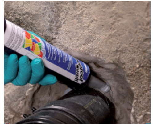
Applikation von Mapeproof Swell ums Rohr
