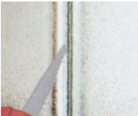
Verfüllen von Glasscheiben mit U-Profil
