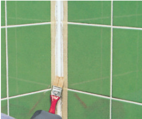
Abglätten der frischen Fuge mit Pinsel und Seifenwasser
