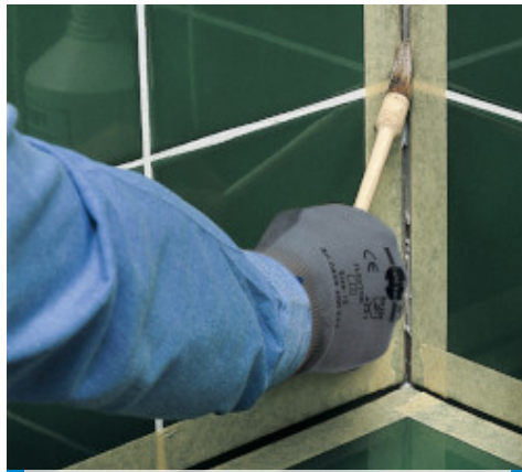
Auftragen von Primer FD
