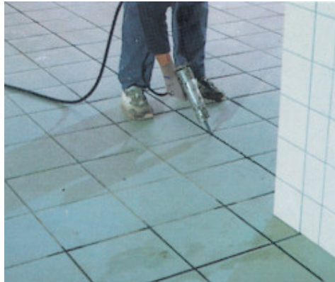
Verfüllung von Dehnungsfugen im Keramikbelag
