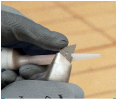
Abschneiden der Kartuschenspitze entsprechend der Fugengröße
