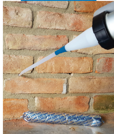
Injizieren Sie MAPESTOP CREAM in jedes Bohrloch
