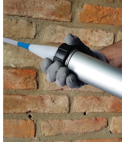
Verschließen Sie die Kartuschenpistole und fügen Sie vorher die Injektionsspitze ein
