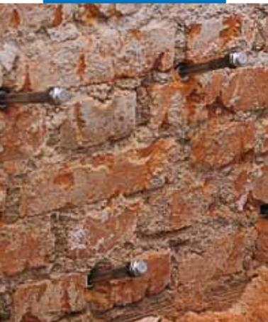
Injektionsvorrichtung im Detail
