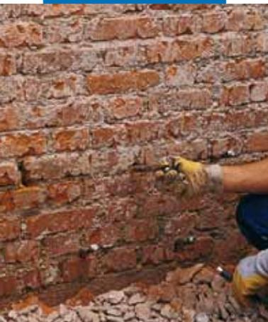
Einführung der Injektionsvorrichtung in Bohrloch
