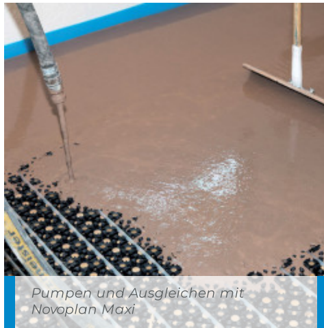
Verwendung von Novoplan Maxi zur kompakten Einbettung von Heizsystemen
