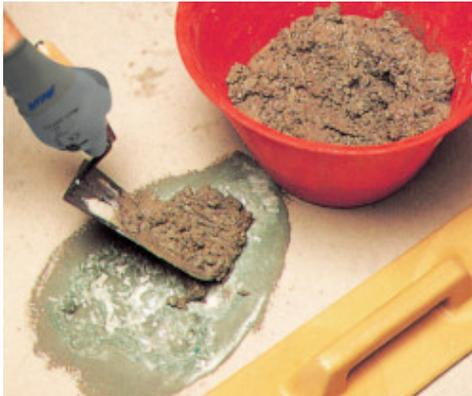
Partielle Reparatur: Auftragen des Mörtels
