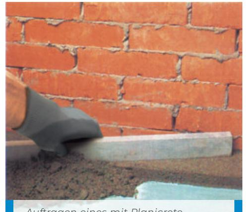
Auftragen eines mit Planicrete vergüteten Zementestrichs
