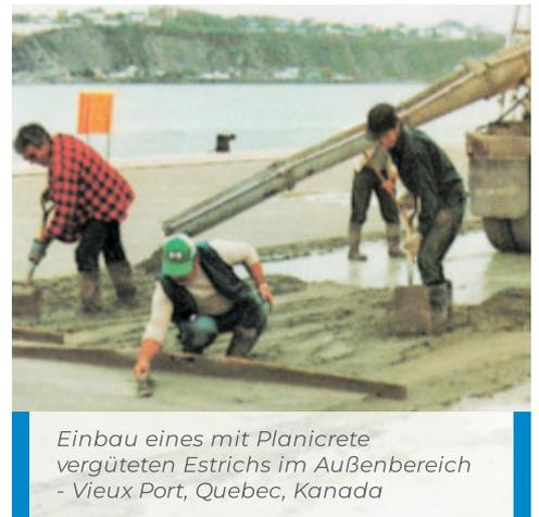
Einbau eines mit Planicrete vergüteten Estrichs im Außenbereich - Vieux Port, Quebec, Kanada
