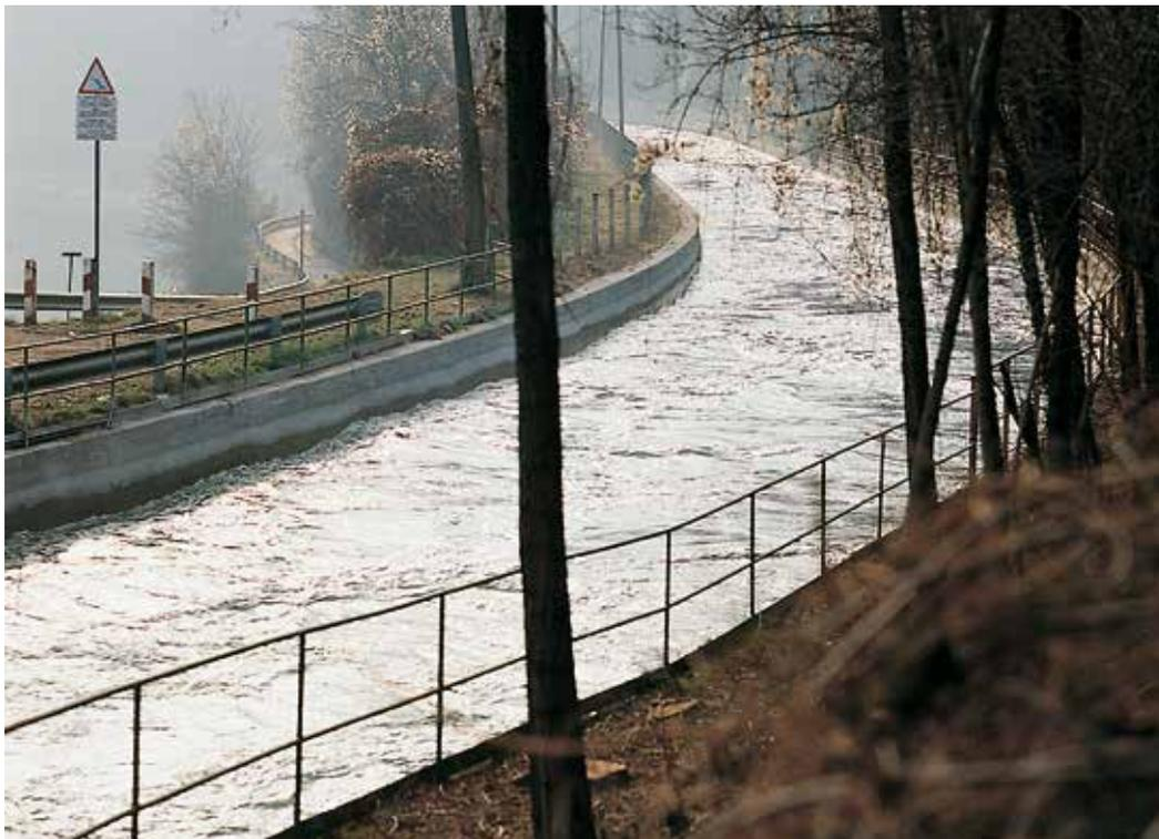
Kanal des Wasserkraftwerkes Bertini-Robbiate (I) nach Abdichtung mit Planiseal 88
