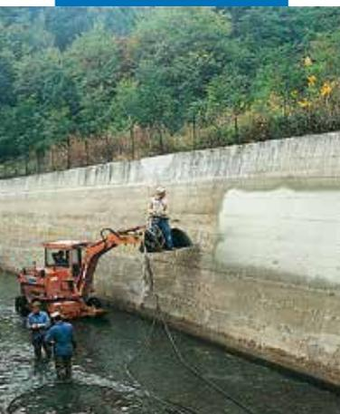
Verarbeitung von Planiseal 88 im Spritzverfahren in einem Kanal einer Wasserkraftanlage
