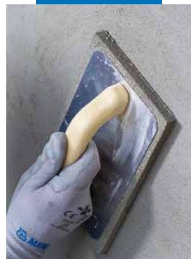
Oberflächenglättung von Planitop Rasa & Ripara R4 mit Schwambrett
