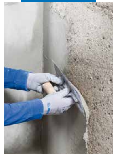
Auftragen von Planitop Rasa & Ripara R4 mit einer Spachtel
