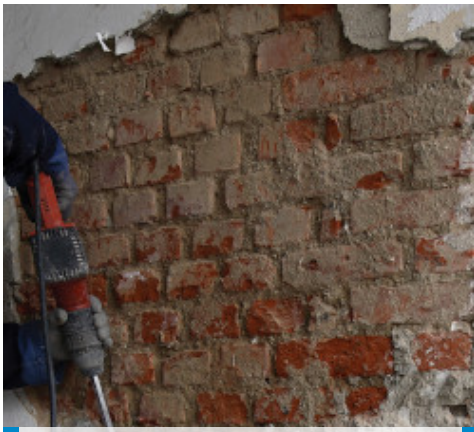
Entfernen des vorhandenen Putzes
