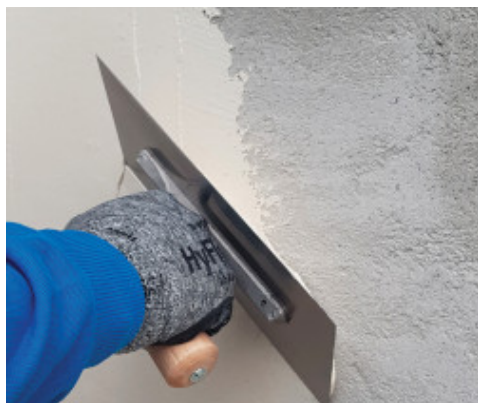
Applikation von PoroMap Finitura Civile auf ausgehärtetem Putz
