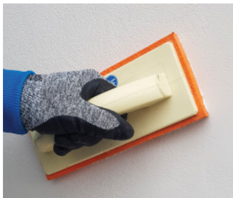
Abreiben von PoroMap Finitura Civile mit einem Schwammbrett
