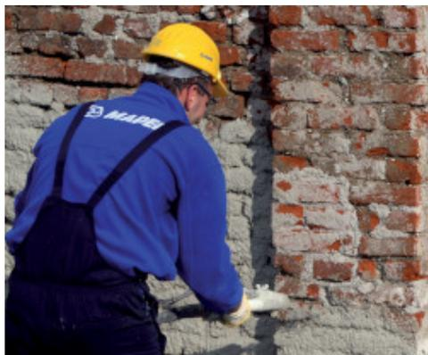
Auftrag von *PoroMap Rinzaffo Plus* mit einer Putzmaschine
