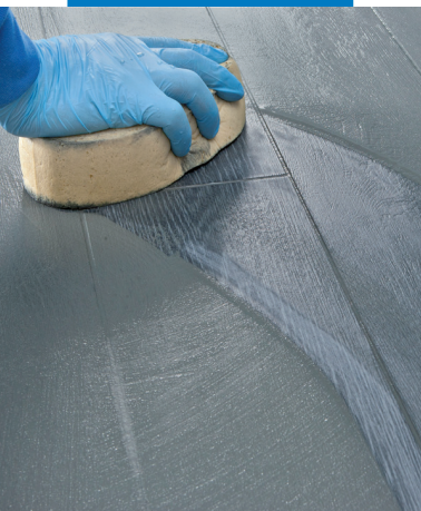
Endreinigung des Fugenmörtels mit einem Schwamm
