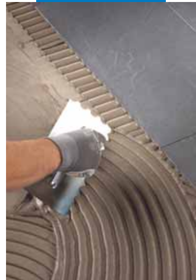
Auftragen des Klebörtels mittels Torbogenzahnung
