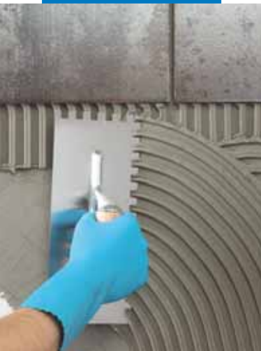
Aufziehen von Ultralite S1 mittels Zahnpachtel an der Wand
