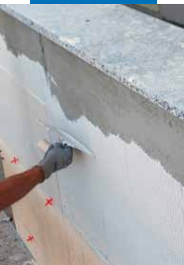
Auftragen des Leichtklebemörtel auf den Untergrund
