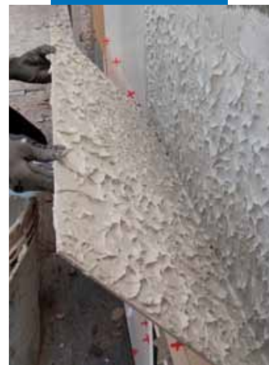
Hervorragende Benetzung zwischen Untergrund und Plattenrückseite
