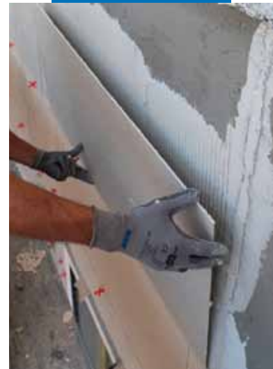
Anbringen einer dünnen Feinstzeugplatte
