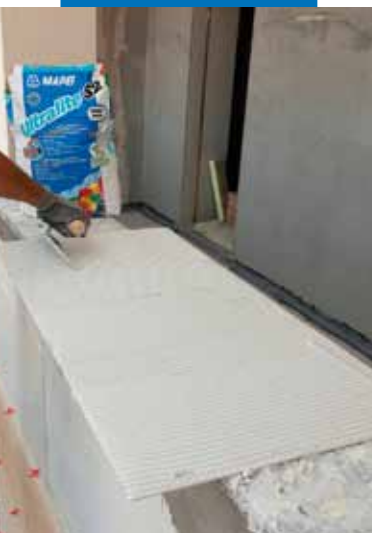
Hervorragende Benetzung der Plattenrückseite
