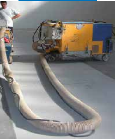
Untergrundvorbehandlung im Kugelstrahlverfahren
