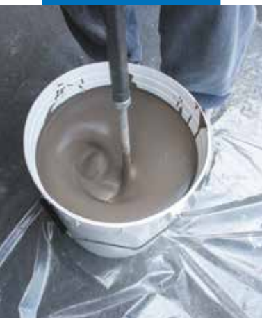
Mischvorgang mit Rührwerk
