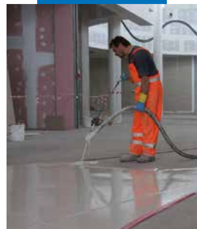
Applikation mit Mörtelpumpe
