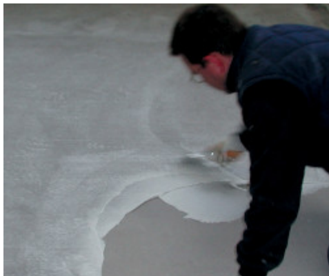
Spachtelung mit Primer MF , gefüllt mit Additix PE
