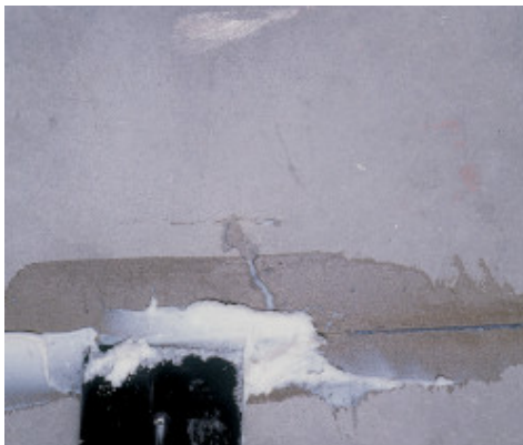
Fugenverfüllung mit Primer MF , eingestellt mit Additix PE
